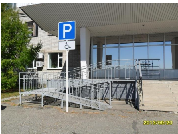
Доступный вход со стороны улицы Будника, д. 119
