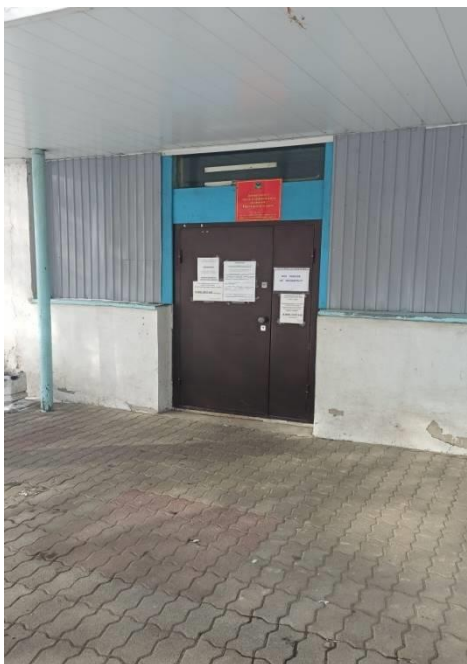
Вход со стороны улицы
