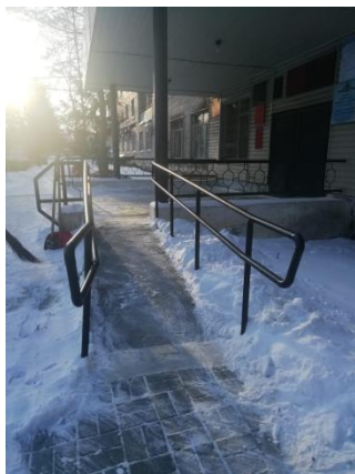
Вход в здание
